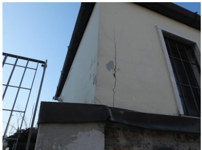
Figura 27 - Figura 28 Lesione all'angolo nord-est
