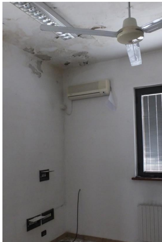
Figura 23 - Infiltrazioni in corrispondenza alle lesioni della guaina
