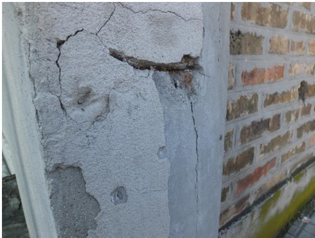
Figura 25 - Figura 26 – Espulsione del copriferro nei pilastri in C.A.
