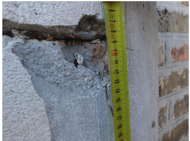
Figura 25 - Figura 26 – Espulsione del copriferro nei pilastri in C.A.
