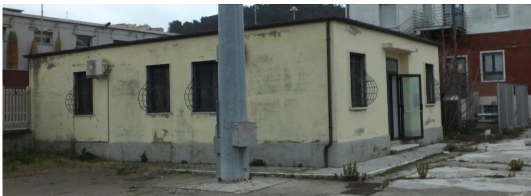
Figura 24 - Muratura esterna con segni di umidità di risalita
